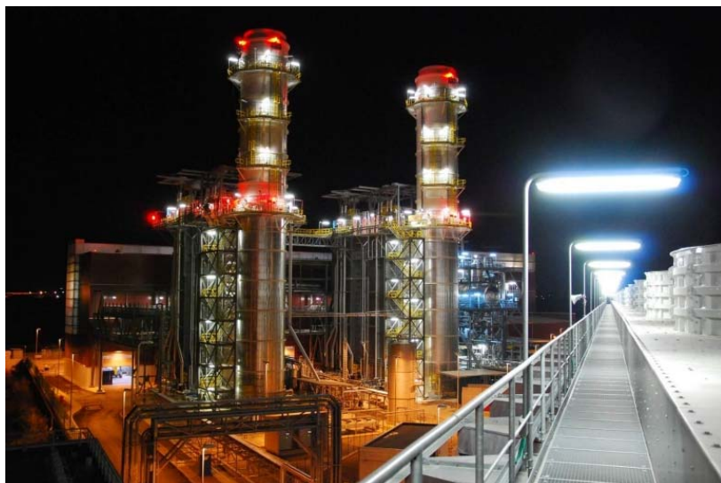
Figura 5 – Foto in notturna della Centrale
